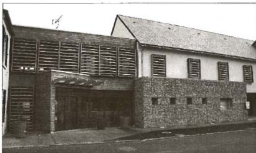
Du coup, la liste des travaux va encore s'allonger dans cet immeuble.
