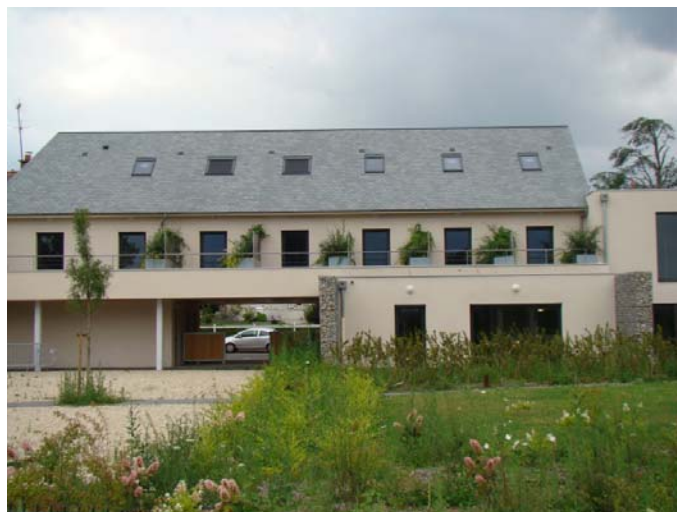
Les fenêtres de toit de l'appartement du gérant
